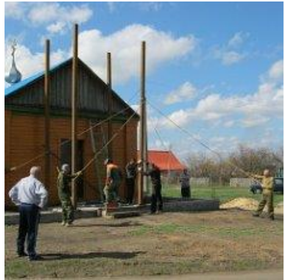
Начало возведения колокольни. Апрель 2011г.
