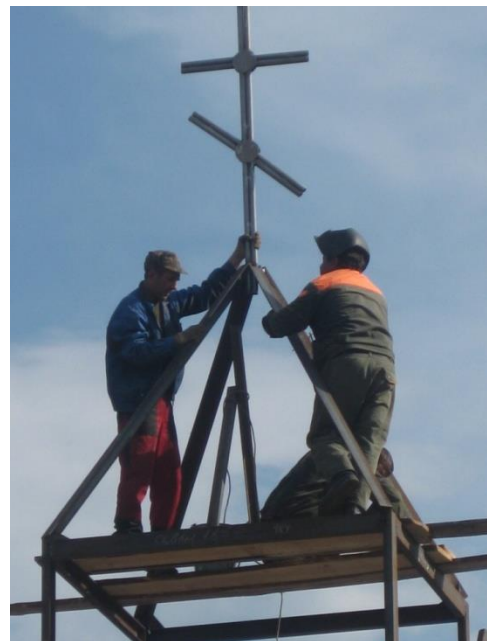
Установка креста на колокольню. Июнь 2011г.
