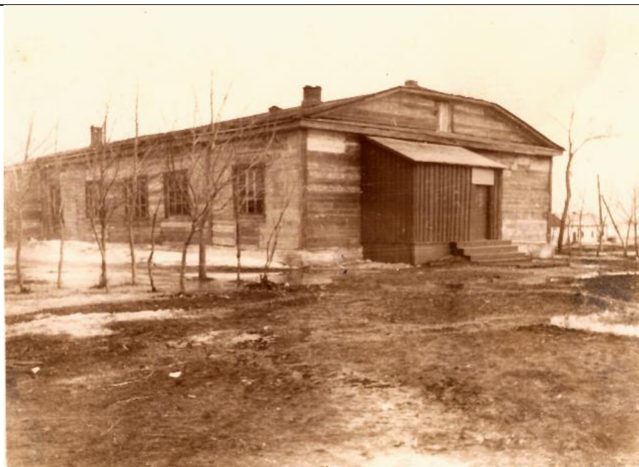
Школа в здании бывшей церкви села Александровка. Апрель 1969г.
