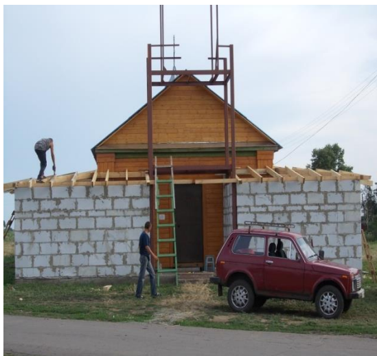
Пристройка трапезной и котельной. Июнь 2011г.
