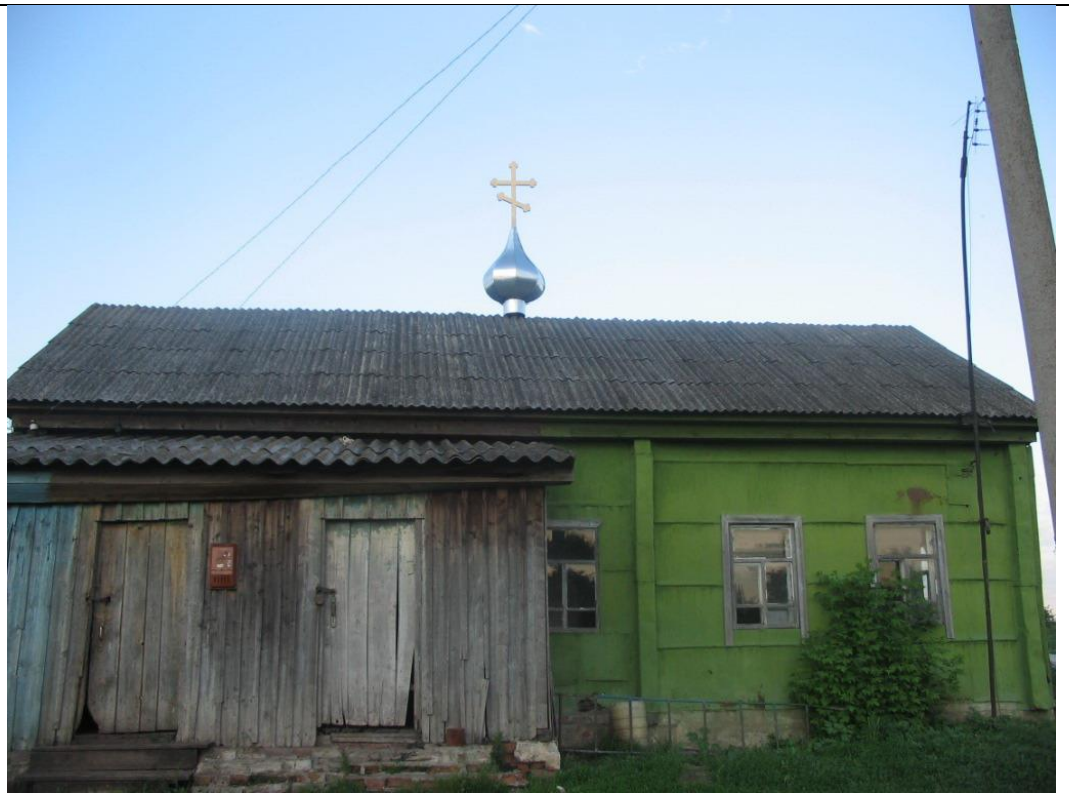
Начало строительства храма. Установка купола на здание будущего храма. Август 2008г.
