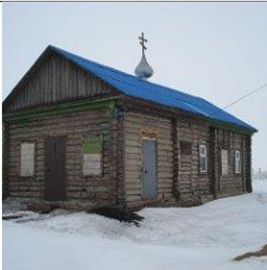
Утепление стен и покрытие шифером. Декабрь 2009г.
