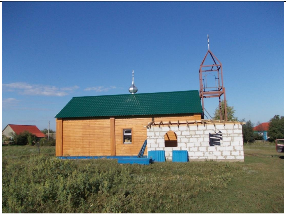
Покрытие крыши металлочерепицей. Август 2011г.
