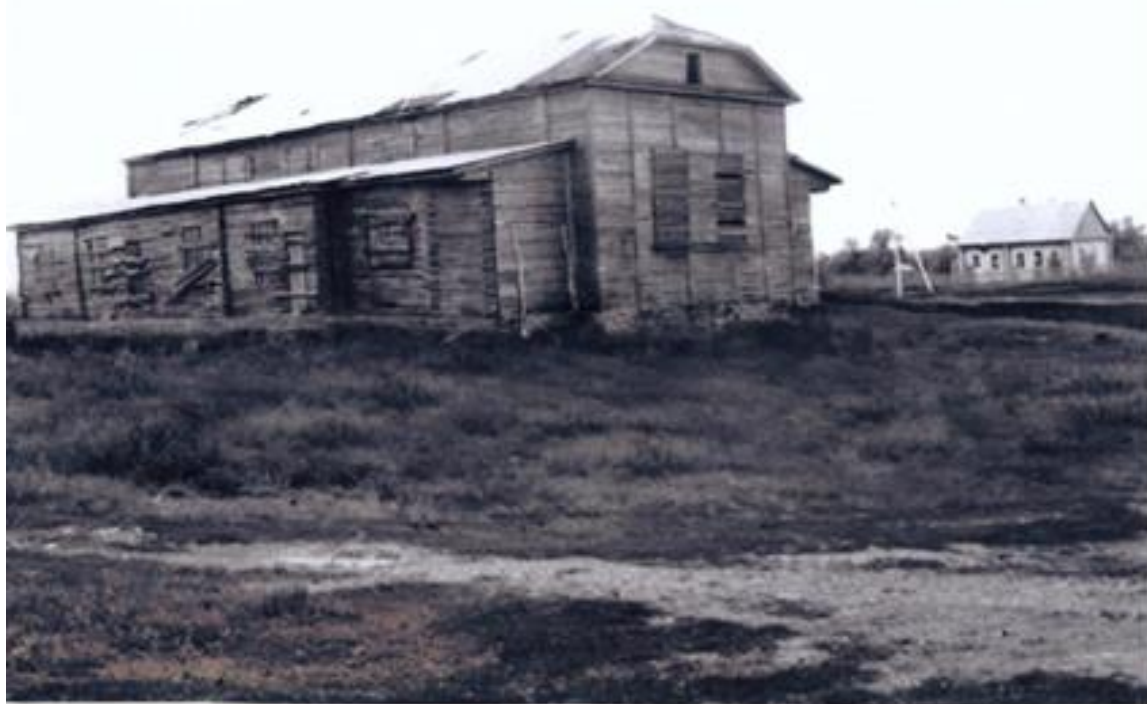
Вид здания бывшего копильского храма. Май 1979г. Здание сгорело в 2004г.
