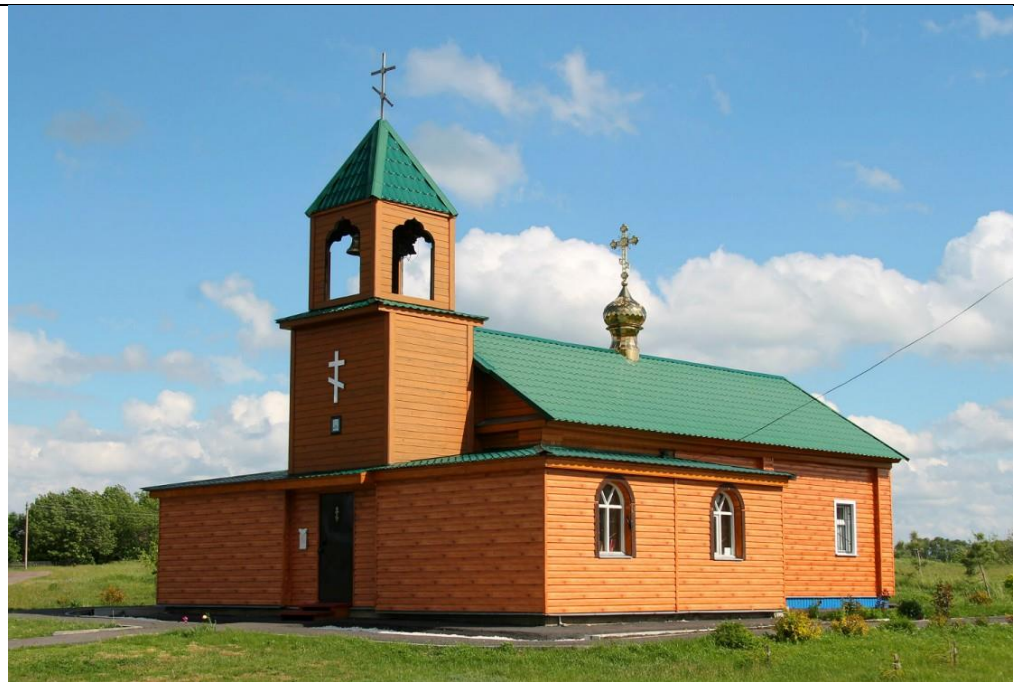
Вновь построенная церковь Архистратига Михаила. Май 2020г.
